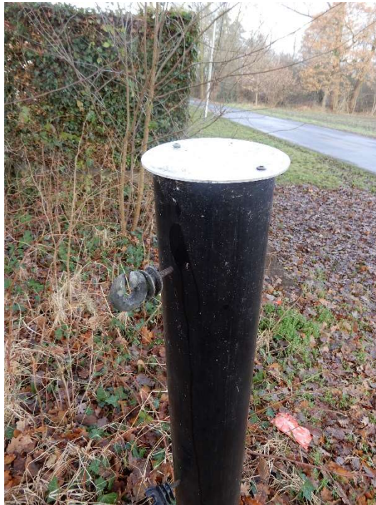
(Vorbildlich „entschärfte“ Kunststoffröhre. Foto: W. Oppel)
