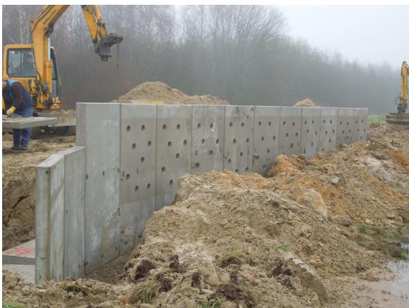
Die künstliche Uferschwalbensteilwand wird aus einzelnen Betonelementen zusammengesetzt (Foto: BUND)
